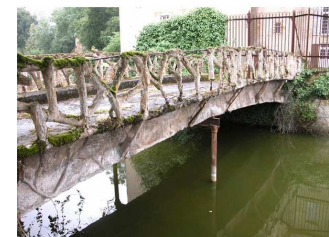
Pont bi-poutre de Chazelet, 1875, Joseph Monier
